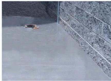
Mortero autonivelante para aplicaciones de recredido en capa fina, en espesores comprendidos entre 2 y 10 mm.
