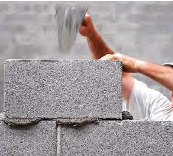
Mortero seco fabricado en central según Norma UNE EN 998-2, destinado a ser utilizado en construcciones interiores y exteriores.
