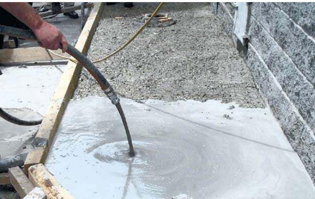
Mortero autonivelante para aplicaciones de recredido en capa gruesa, en espesores comprendidos entre 3 y 10 cm.
