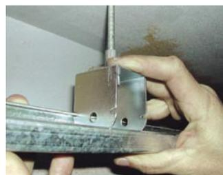
3. Se insertan las horquillas en el perfil mediante una ligera presión.
