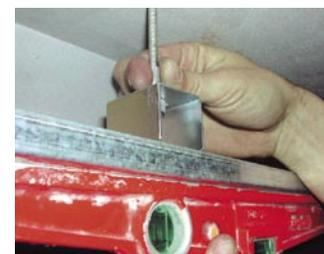
4. Si hay algún defecto en sus nivelación, nos permitirá modificar ésta, a través del propio casquillo sin tener que soltarlo del perfil.
