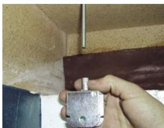
1. Una vez suspendidas las varillas del forjado, procederemos a insertar las horquillas en la misma, a través del casquillo giratorio con rotura de puente térmico.
